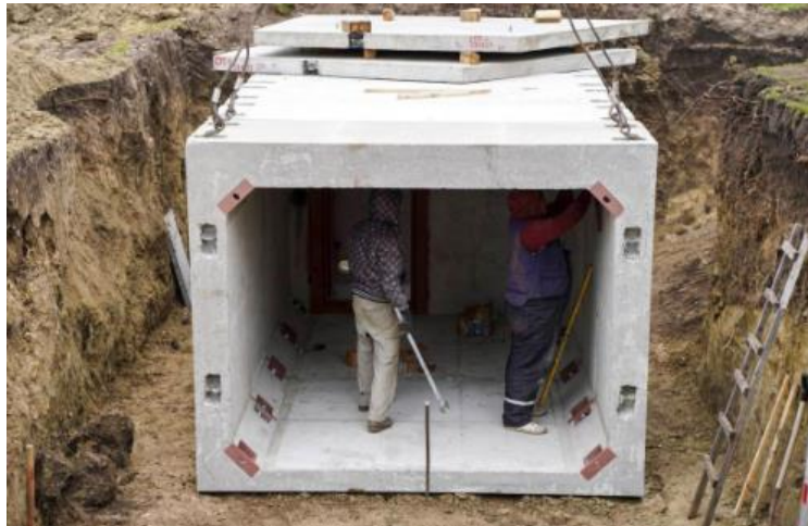
Attēls. Dzelzsbetona bloku konstrukcijas 7
